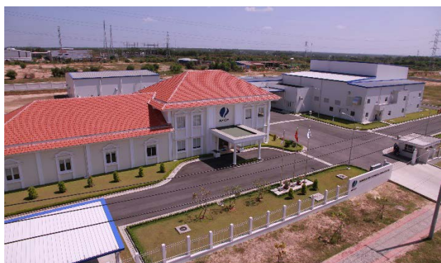
AFCP 社ロンタン工場（第二工場）外観
